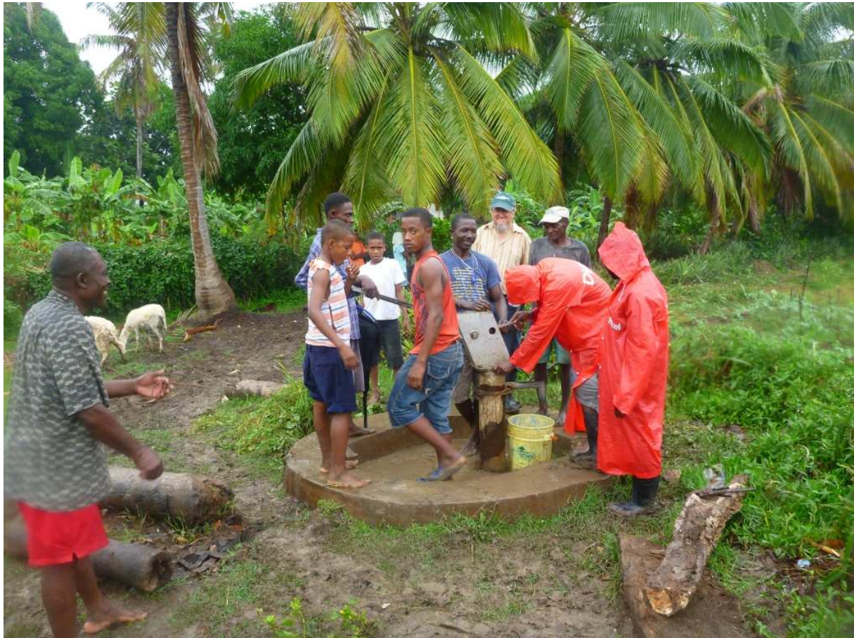
Eine Wasserpumpe wird repariert auf Ile à Vache / Haiti
